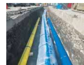
▲耐震性の高い水道管へ取替工事
