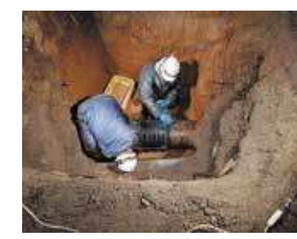
▲老朽化により漏水した水道管の修繕工事
