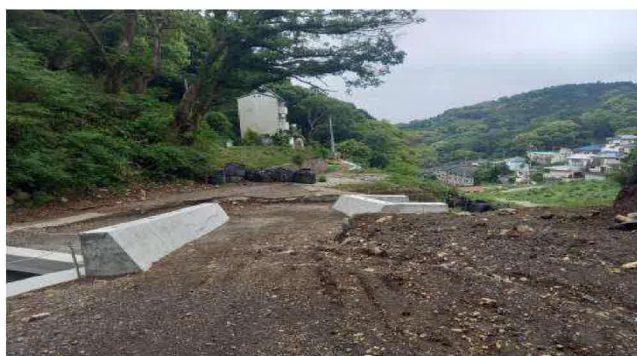
B 道路工事 市道引地堀坂支線 R7.5
