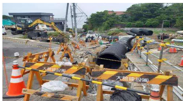
E 河川・道路工事 市道岸谷本線 R7.5
