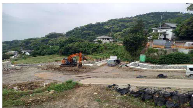
D 道路工事 市道伊豆山神社線取付部 R7.5
