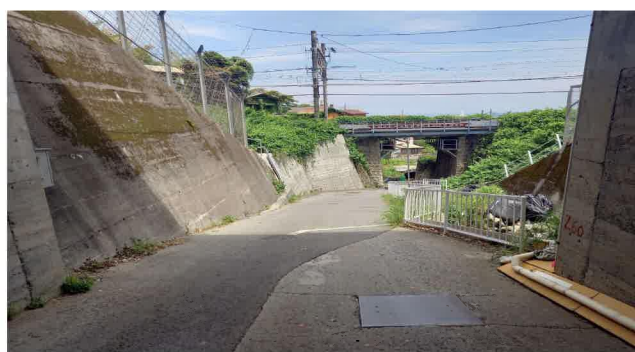
F 河川工事 市道岸谷本線(暗渠部) R7.5
