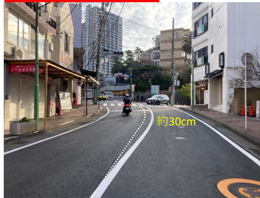
対策後（市道側）
