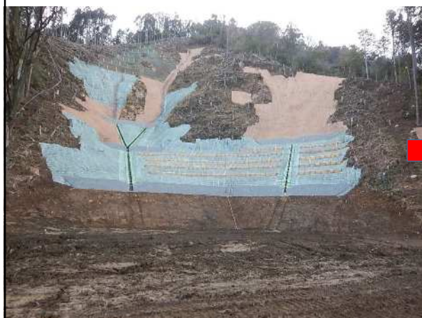
R4年3月撮影 (工事完了直後)
