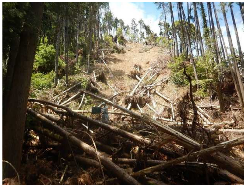
伊東市 山腹工① (発災後の状況)
