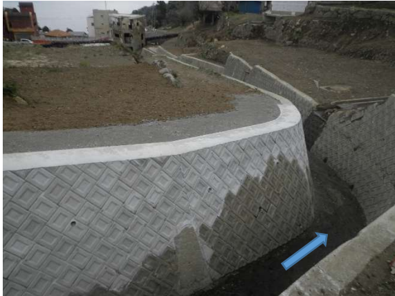
災害復旧工事施工済箇所 （コンクリートブロック積工）
