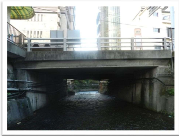
【RC 橋】 染殿橋（熱海駅和田浜線）
