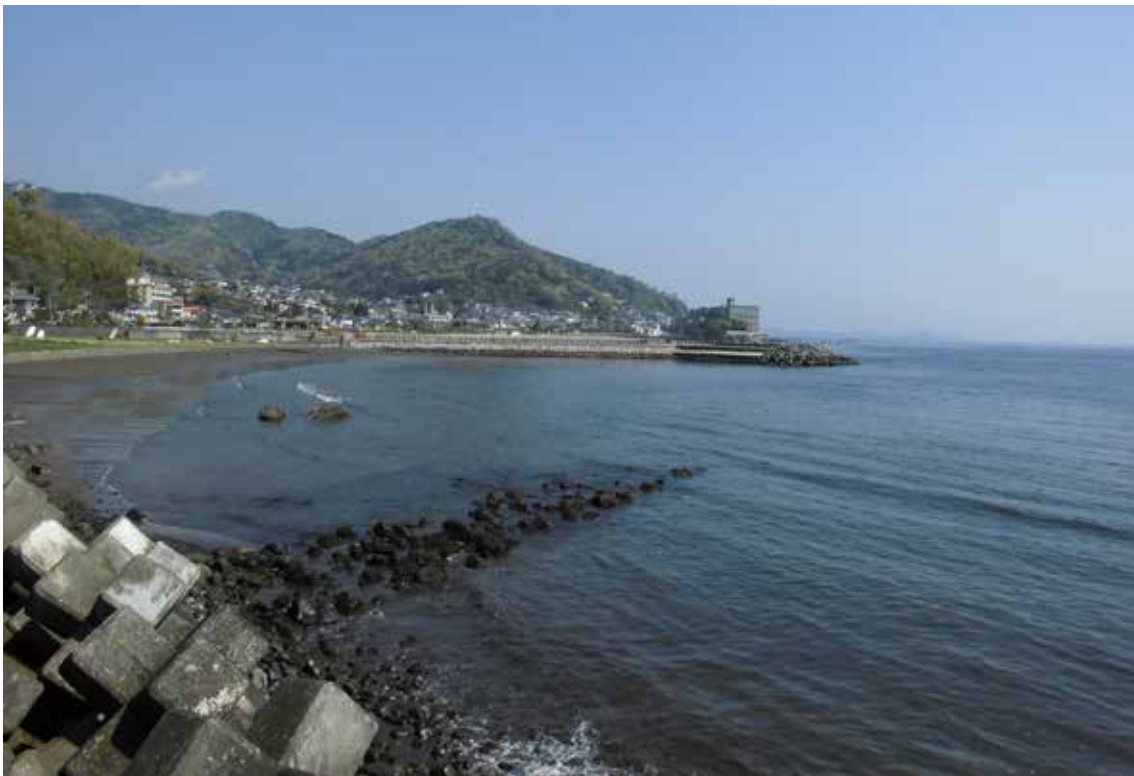
4. 伝築城石船積場跡遠景
