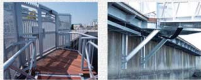
張り出しデッキ
