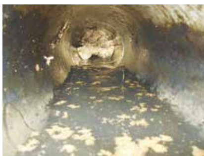
油が付着して、詰まった下水道管
