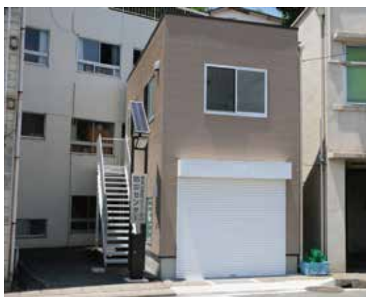
伊豆山地区コミュニティ防災センター
