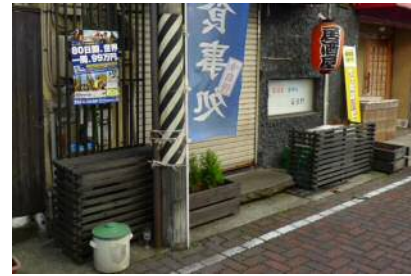
空調室外機の修景
