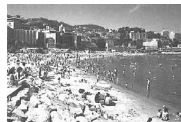
熱海サンビーチ 施工後
