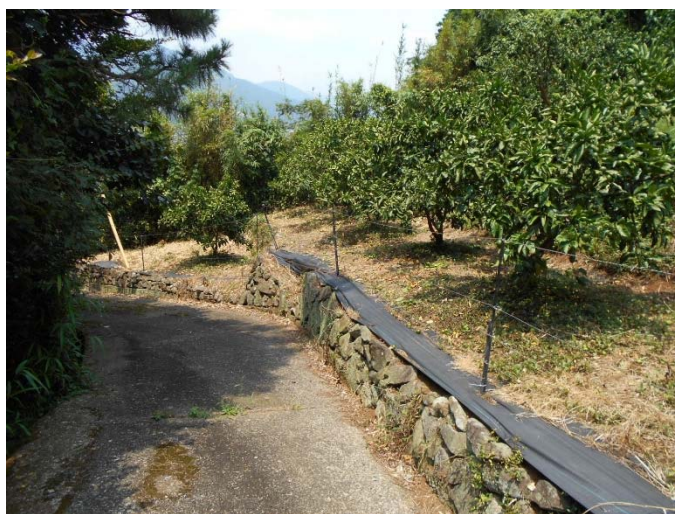
電線・支柱の設置状況
