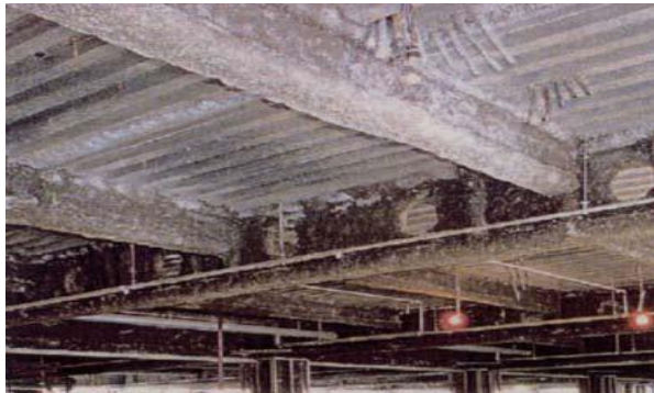
耐火被覆材：柱・梁
