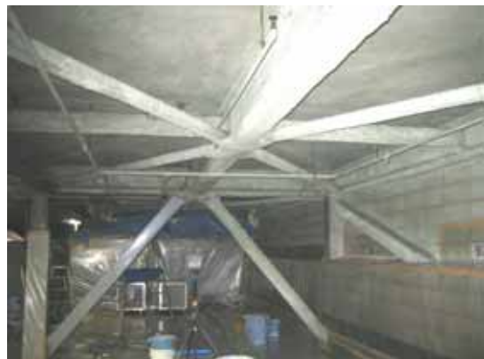
図表 3-27 同上施工区画の内部側
