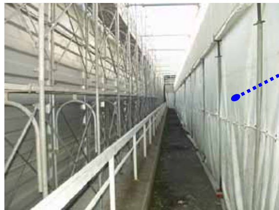
図表 3-46 外壁開口部の飛散防止措置 (開口部全面に防災シートを張った。詳細は図表 3-49)
