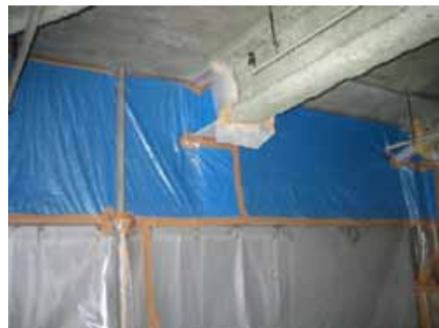
図表 3-37 壁面の隔離養生例(作業場内側)
