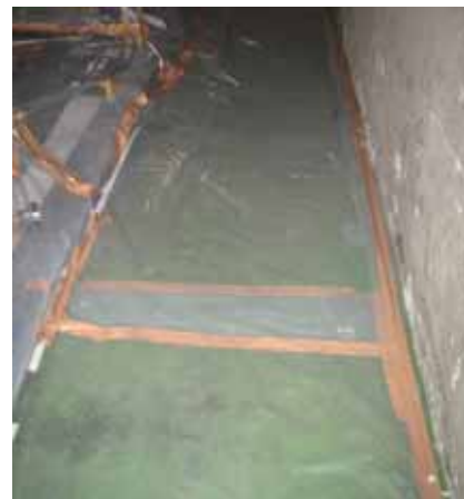
図表 3-36 床面の養生例(2重張り)
