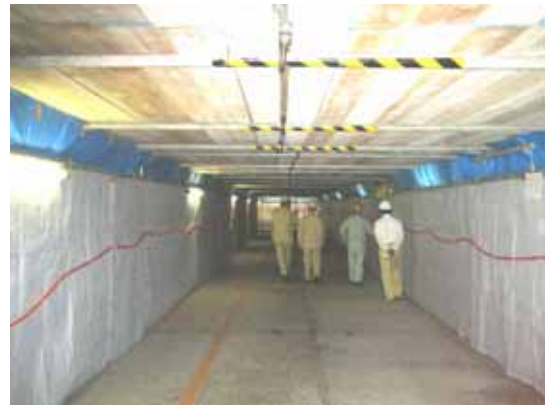
図表 3-26 駐車場ビルにおける施工区画(車路の両側及び上部吊足場が施工区画)
