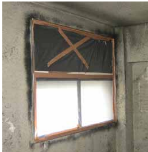
図表 3-39 窓、換気口の養生例
