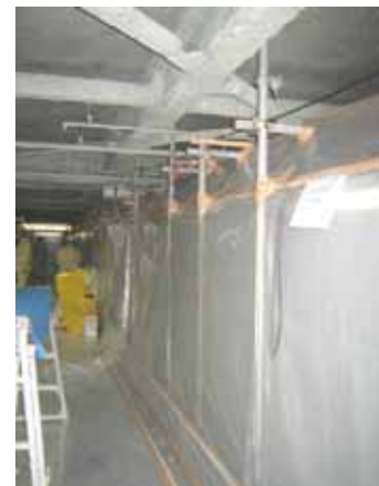
図表 3-28 同上施工区画(内部側、右外側が車路)
