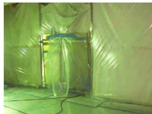
図表 3-38 壁面の隔離養生例 (作業場内側 負圧化のため内側へはらんでいる)
