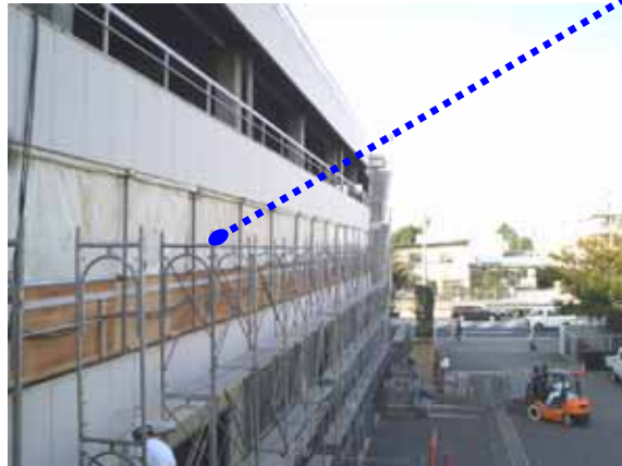
図表 3-45 外壁開口部の飛散防止養生 (既存手すりを活用し、防災シートとベニヤ板を使用して隔離の破損を防止。詳細は図表 5.27)
