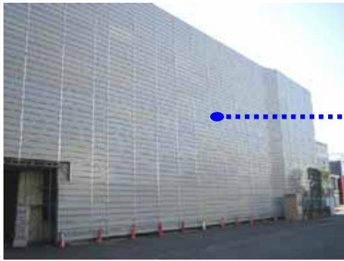
図表 3-44 建屋周囲に設置した、通常の解体工事で使用する防音パネル(枠組足場を取付け、内部の石綿除去工事を視覚的にも遮断)
