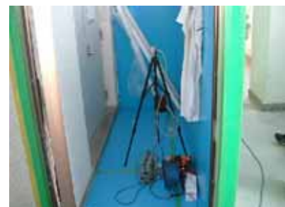
図表 3-30 同左施工区画(内部)
